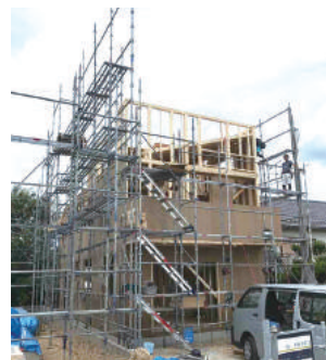
一般構造用合板を大きく上回る壁倍率4.0倍の「ハイベストウッド」を外周に貼りめぐらせている。
